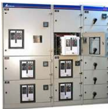
Fig.12. Fijación de interruptores a los armarios.
